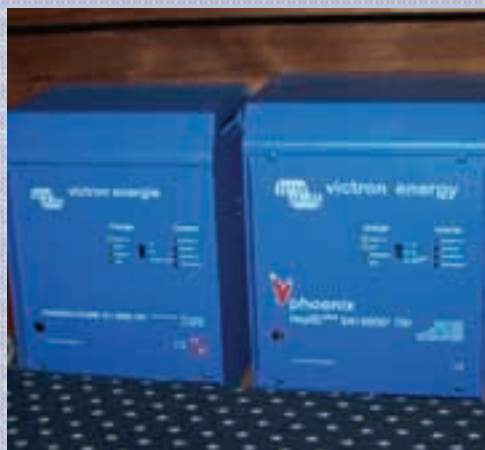
Deze installatie van Victron gebruikt stroom die nog over is voor het laden
